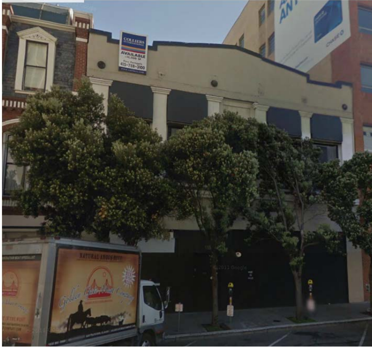
115 Steuart Street façade
