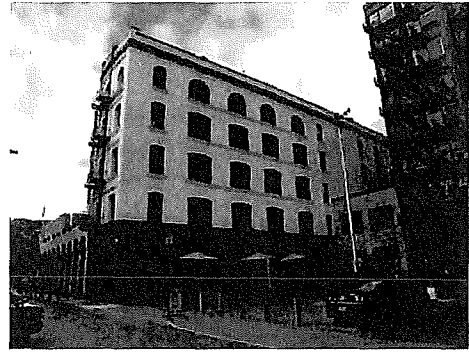
Mint Plaza facade. 3/8/2011. 103_4050.JPG
