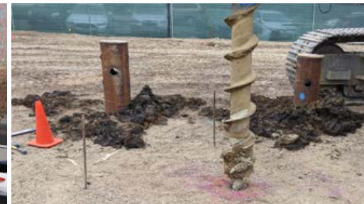
SEHC – Test Torque Pile
