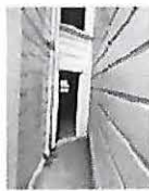
FIG. 2: SINK OVER DOOR
